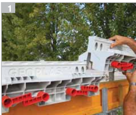
Colocar a Trave Y e a cunha montadas
