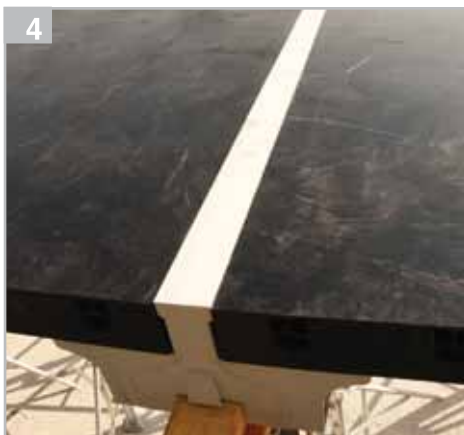
Encaixe do painel na Trave Y
